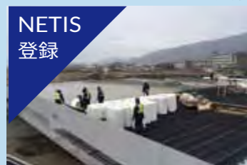
コンクリート養生の湿度管理
